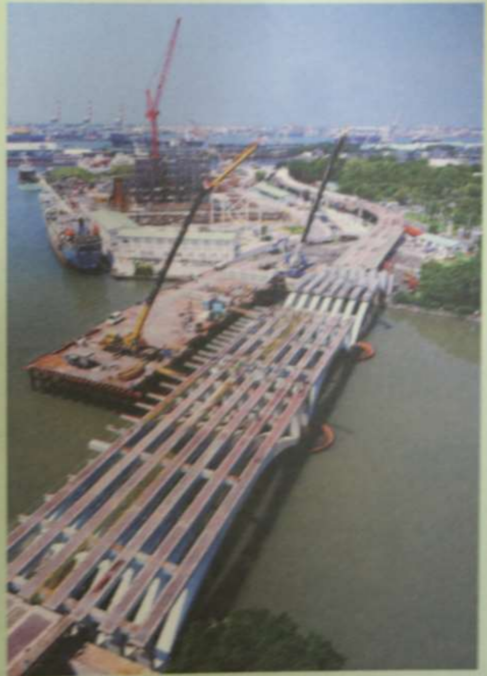
▲高雄輕軌愛河橋第二、三跨吊裝記錄 2016.07~08
